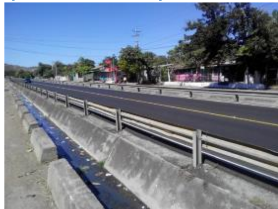
Foto 4 Presencia de cunetones y canalizaciones de drenaje.
