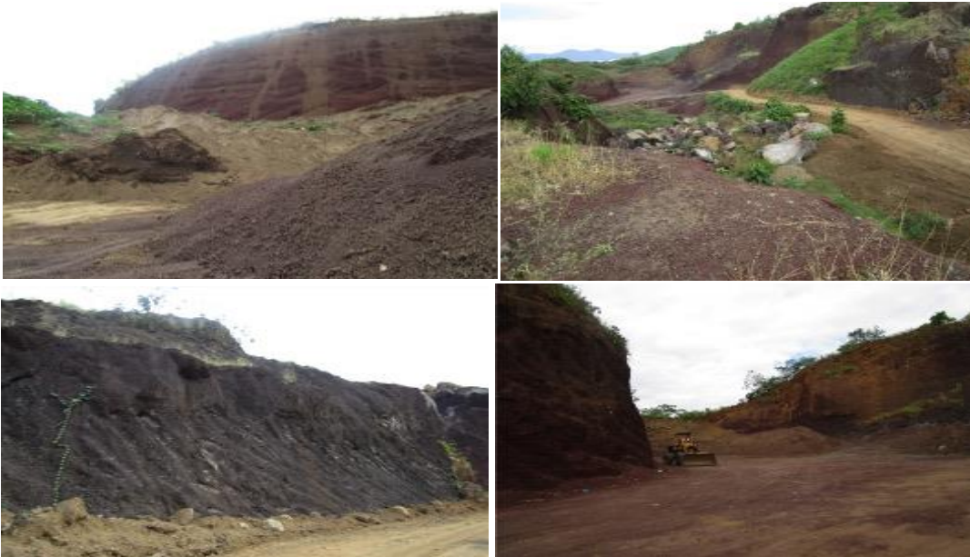
Foto 9 Vista panorámica y Accesibilidad del Banco de Materiales Productos Aliados S, A
